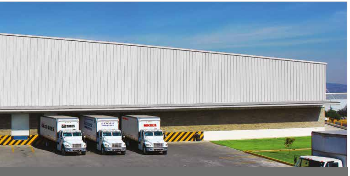
Racks de última generación / 9,980 posiciones en RACKS
