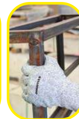
INSTALACIÓN DE ESTRUCTURAS
